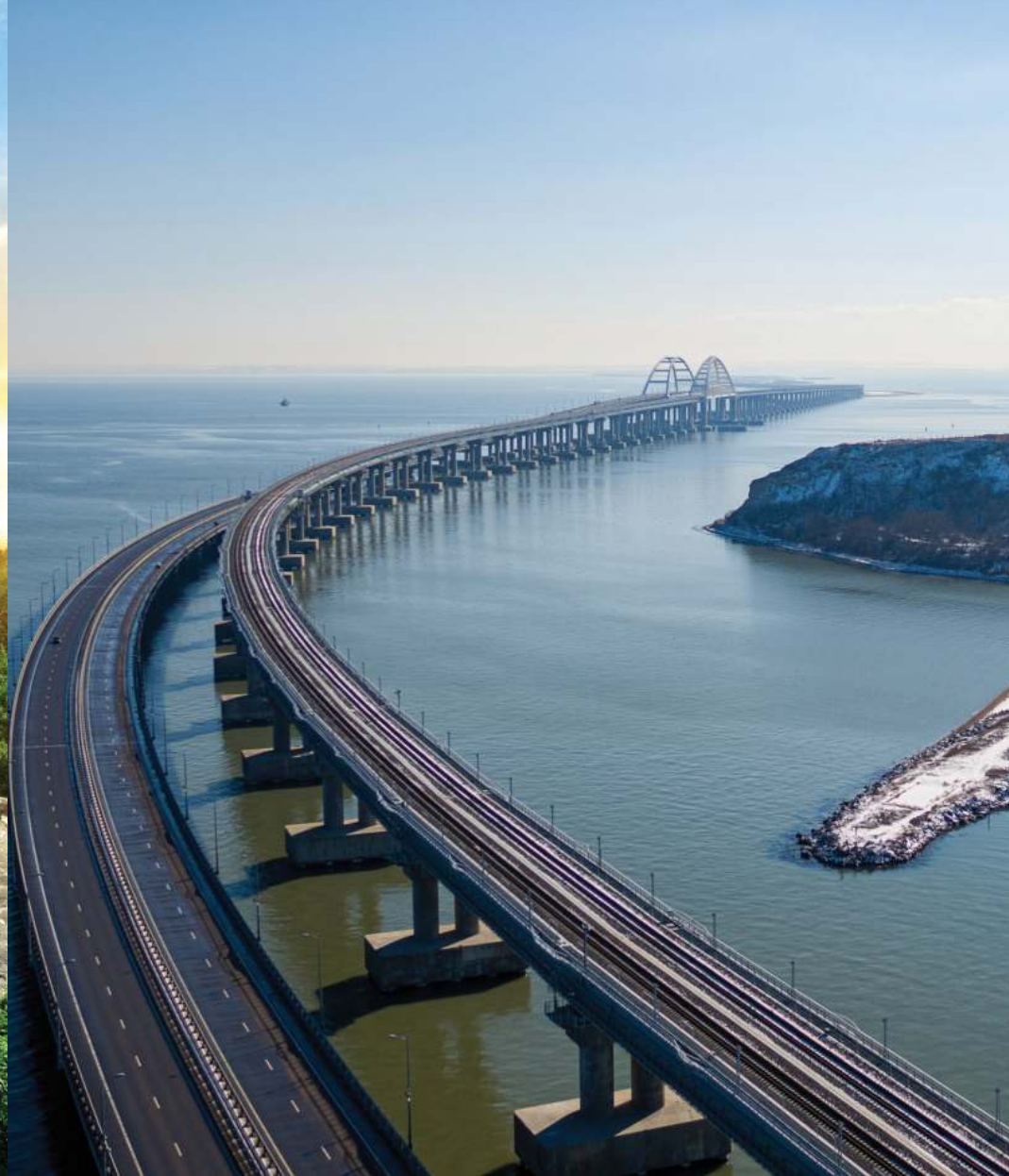
يبلغ طول جسر كيرتش الى ١٩ كيلومترا وهو اطول جسر في روسيا (١١,٥ كيلومترا فوق اليابسة و ٥,٧ كيلومترا فوق سطح البحر).
